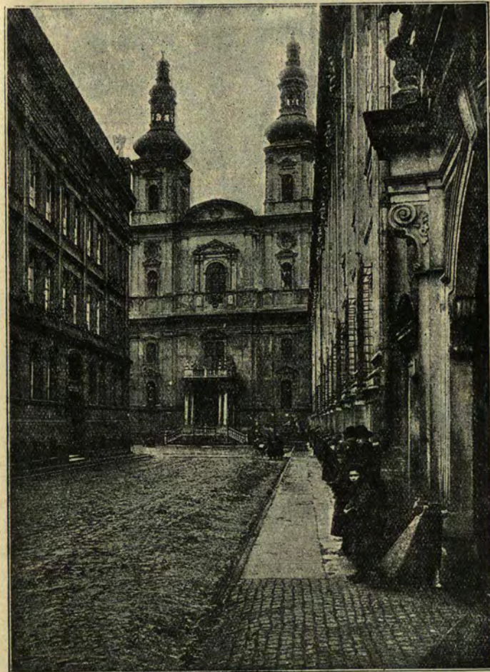
Abbildung 28. Die Jesuitenkirche in Meisse nach der Wiederherstellung der Turmhelme.
