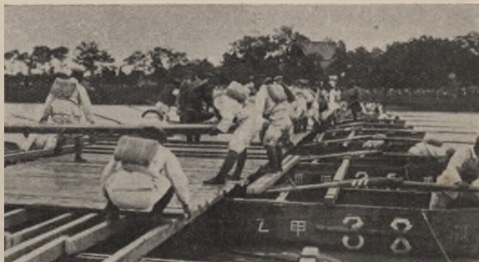
Układanie mostu przez pionierów japońskich podczas manewrów w okolicach Tokio
