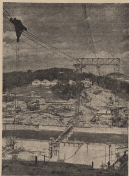
Budowa zapory wodnej w Rożnowie.
