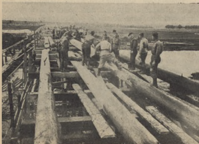
Budowa mostu na wschodnich rubieżach
