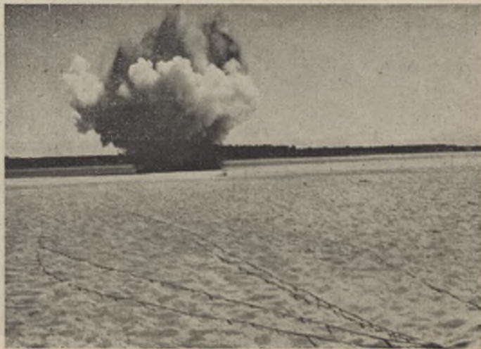
Wysadzanie zatórów lodowych
