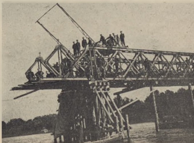
Budowa mostu ciężkiego
