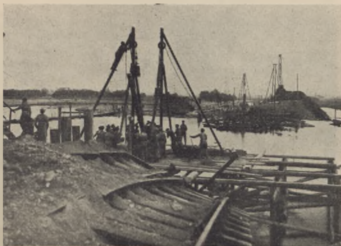
Odhudowa przez saperów kolejowych zniszczonego mostu
