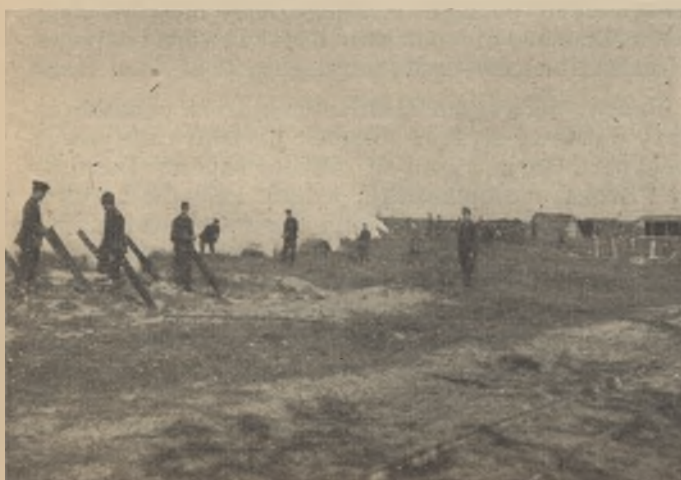
Budowa przeszkód przeciwczołgowych
