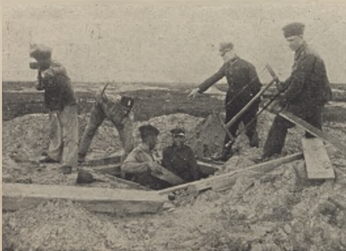
Budowa studni minerskiej
