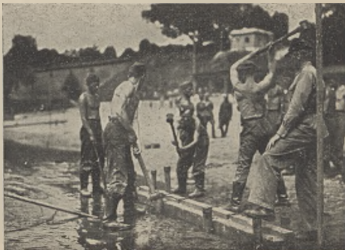
Zakładanie progu
