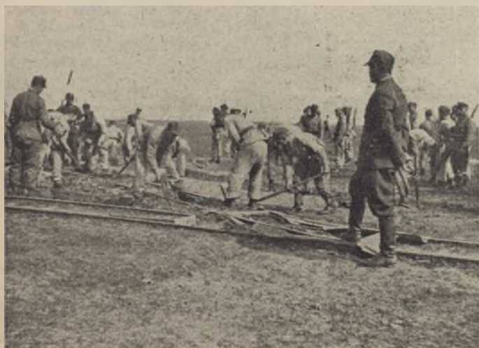
Budowa kolejki wąskotorowej
