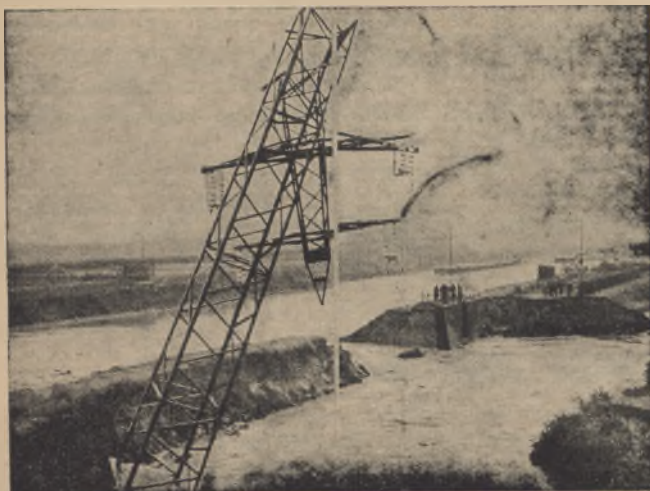
Bardzo niebezpieczne dla otoczenia zerwane przez burzę przewody wysokiego napięcia
