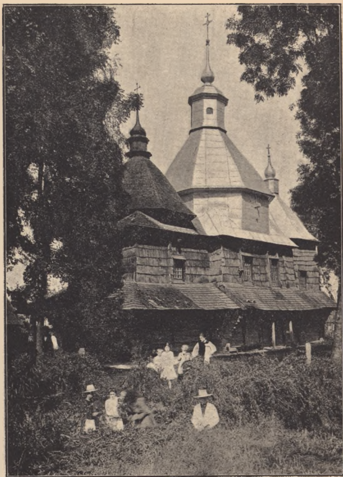
Fig. 15. Cerkiewka św. Michała w Gródku Jagiellońskim. Przykład ujemny krycia blachą budowli drewnianych.
