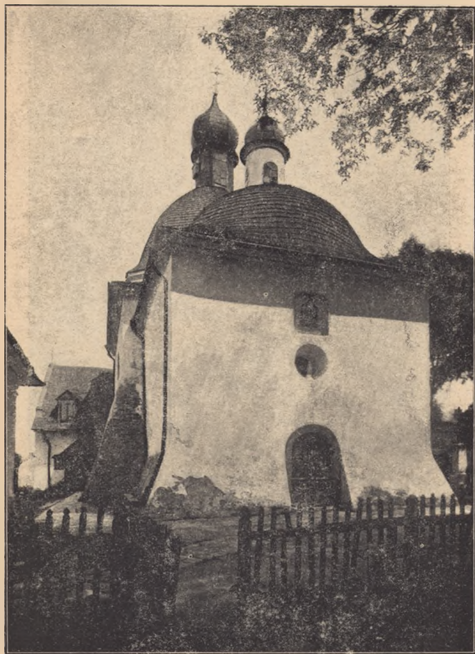
Fig. 16. Cerkiewka św. Mikołaja w Gródku Jagiellońskim. Przykład dołatni krycia gontem budowli murowanych.
