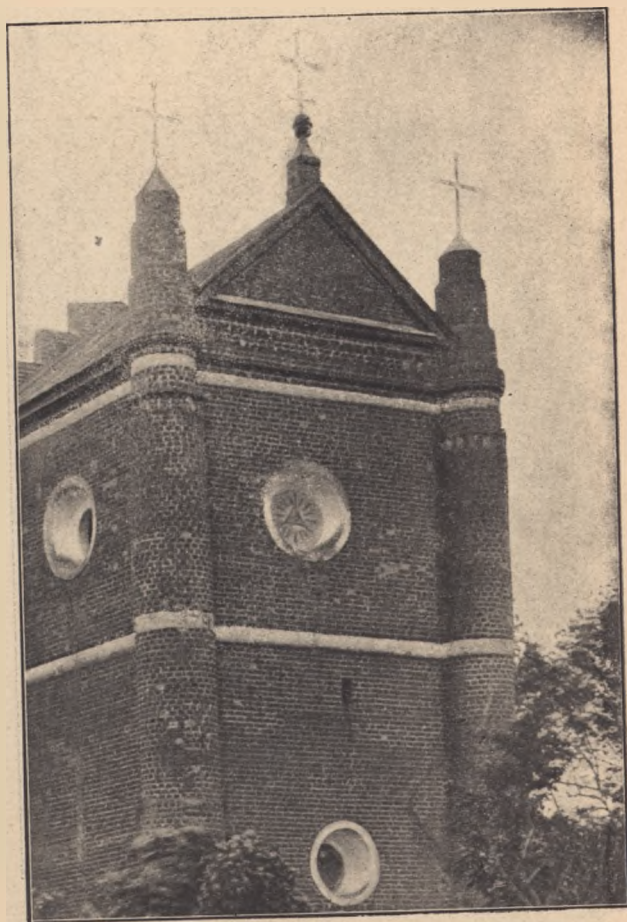
Fig. 19. Fragment kościoła paraf. w Serocku z pierwszej połowy wieku 'XVI. Przykład właściwego zachowania murów ceglanych.
