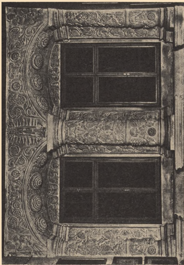
Międzyscieże okienne świetlicy I piętra
