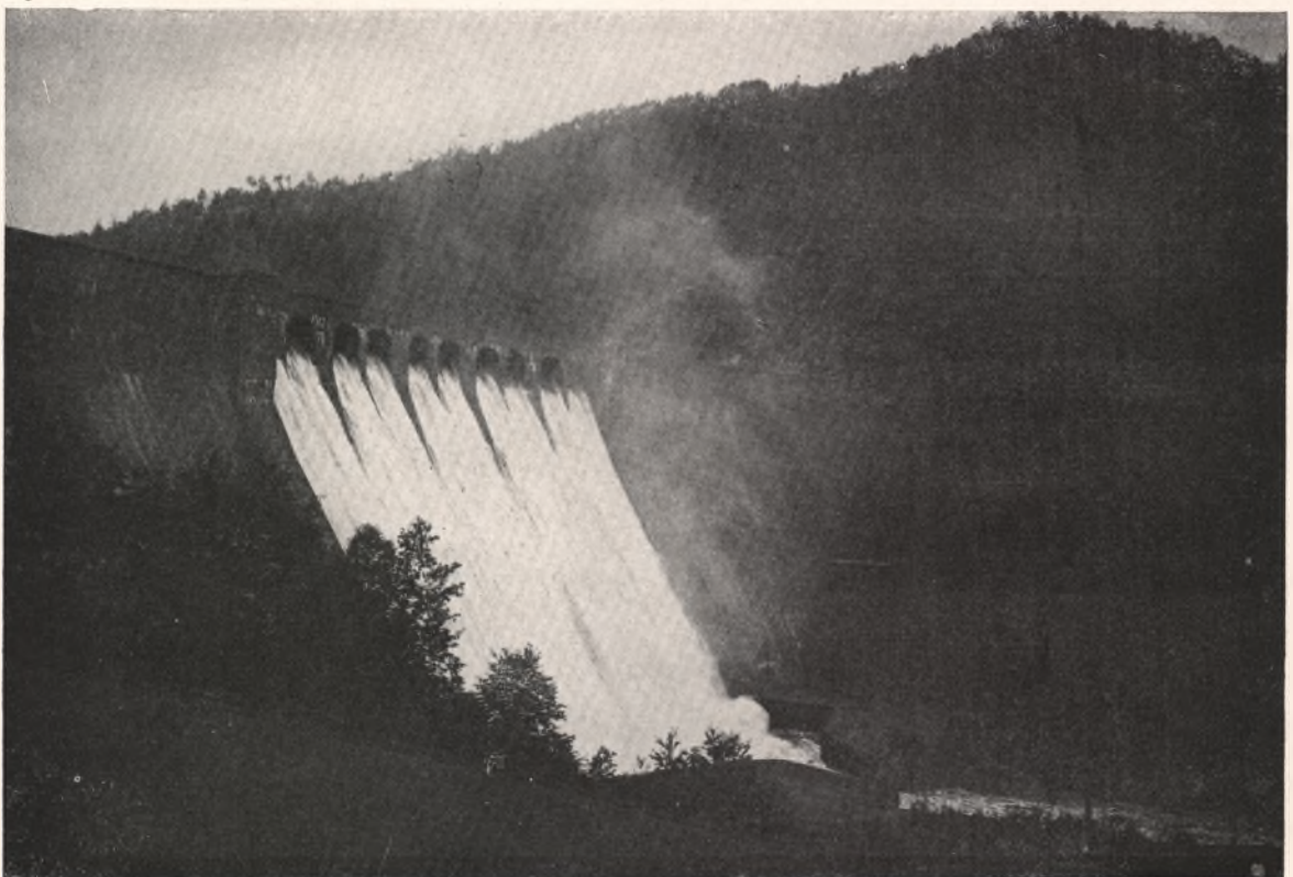
Abb. 4. n Talsperre bei Breitenhain. / Erbaut 1912—1917. / Stauraum 8 Millionen cbm. / Des Stausees Oberfläche 51 ha; Länge 3,3 km. Länge der Sperrmauer 230 m. / Höhe der Sperrmauer vom Felsgrunde 44 m. / Breite am Felsgrunde 29 m. Im Kraftwerk ca. 1000 m unterhalb der Sperrmauer: 3 Turbinen — 2 \times 720 + 290 PS — 1730 PS. / 3 Drehstrom-Erzeuger 2 \times 685 + 275 kVA — 1645 kVA. / Durchschnittliche Jahresleistung: 4 Millionen Kilowattstunden.
