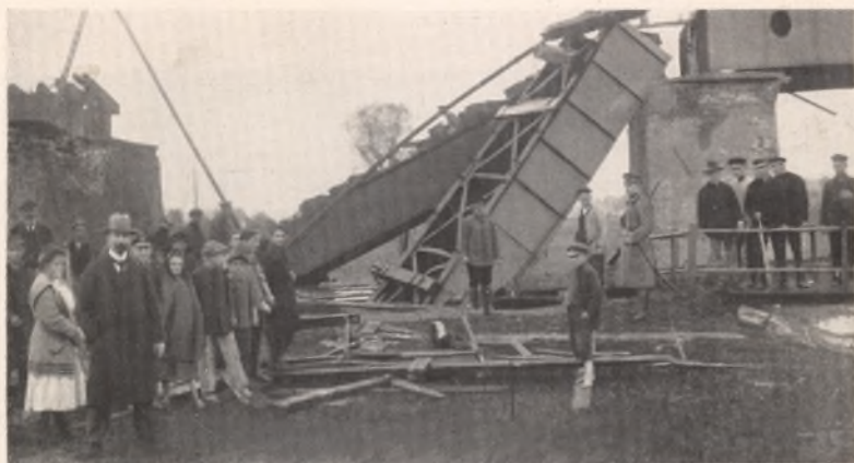
Sprengung der Oppelner Brücke
