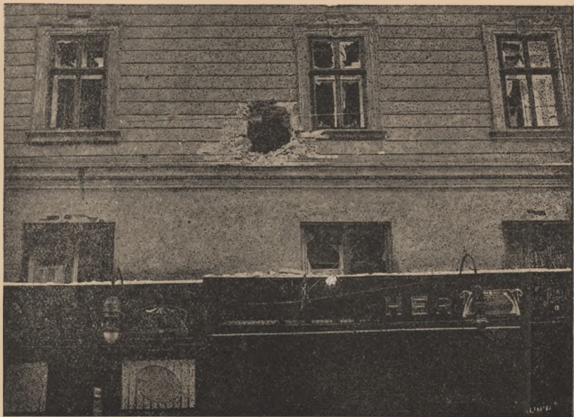
Dom na pl. Kapitulnym zniszczony granatem.
