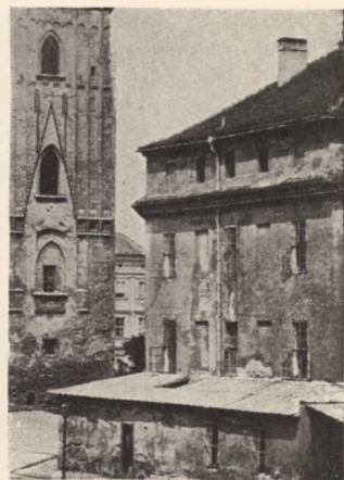
Budynek Wagi Miejskiej krakowskiej.
