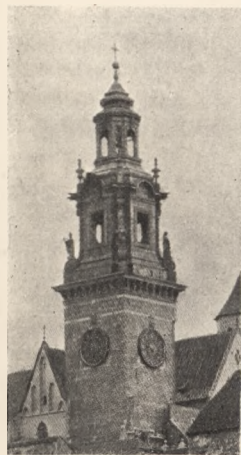
Hełm wieży Zegarowej na Wawelu, XVIII w.
