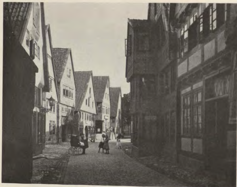
46. Straße in Detmold
