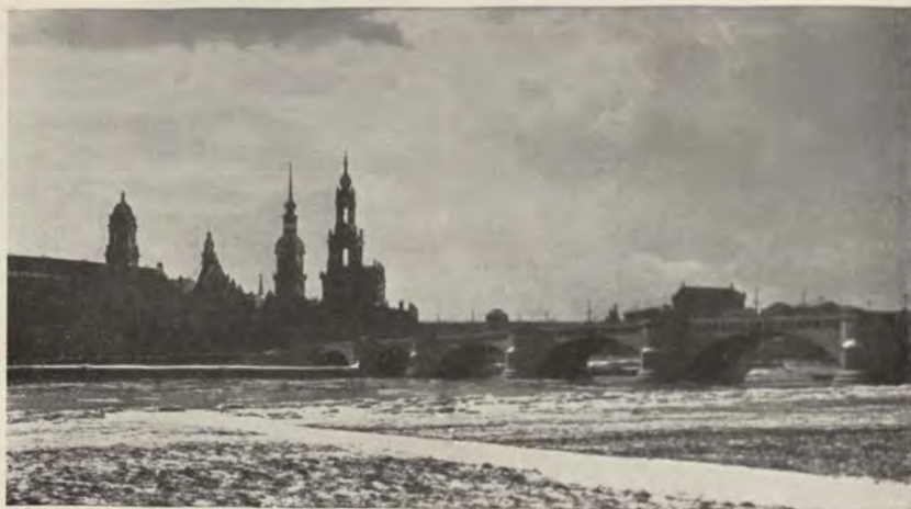
88. Dresden mit der neuen Elbbrücke
