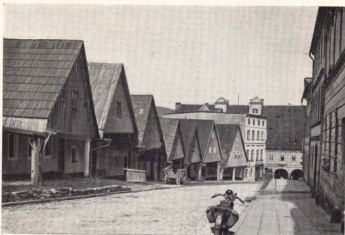
Holzlauben mit verbrettertem Giebel Mittelwalde.
