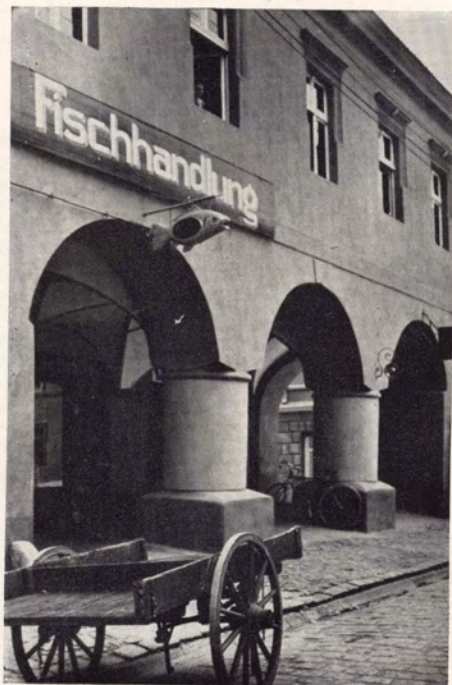
Massive Rundsäulen tragen wichtige Bögen (16. Jahrh.) Jauer.
