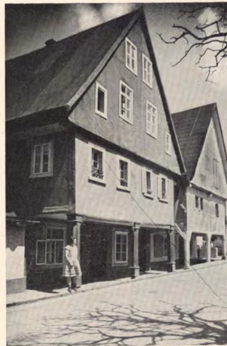
Fachwerkbauten mit vorgefragtem Giebel in unschöner Weise mit Dachpappe benagelt Schönberg, Kr. Landeshut.
