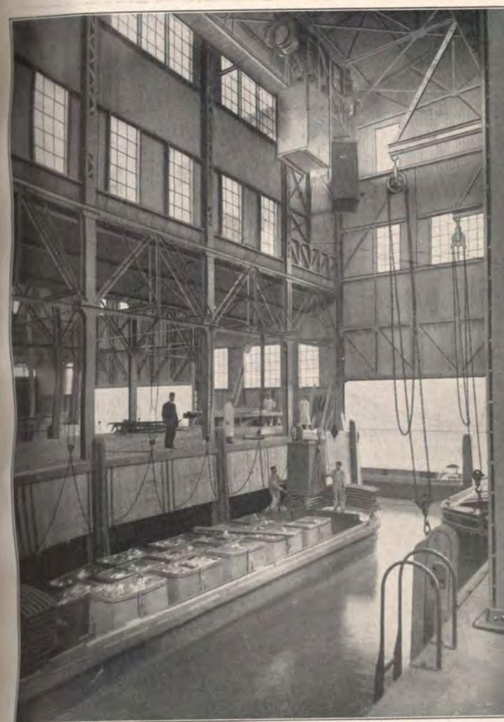
3. Entladen der Müllschiffe durch Aufzüge in Rotterdam.
