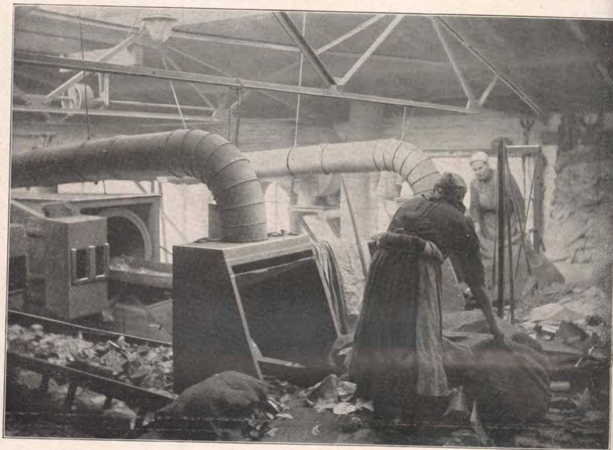
1. Entleeren der Müllsäcke in die Sortieranlage. Aufnahme aus der „Dreiteilung“ von Charlottenburg.
