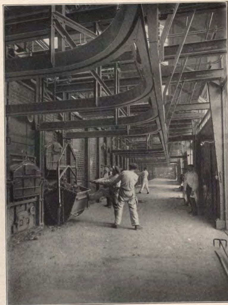
4. Entschlacken der Müllverbrennungsöfen in die Wagen einer Schwebbahn zu Rotterdam.
