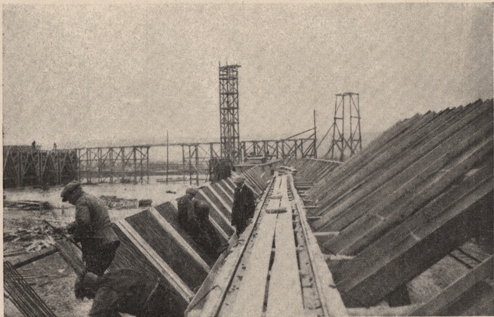
Roboty przy kesonach
