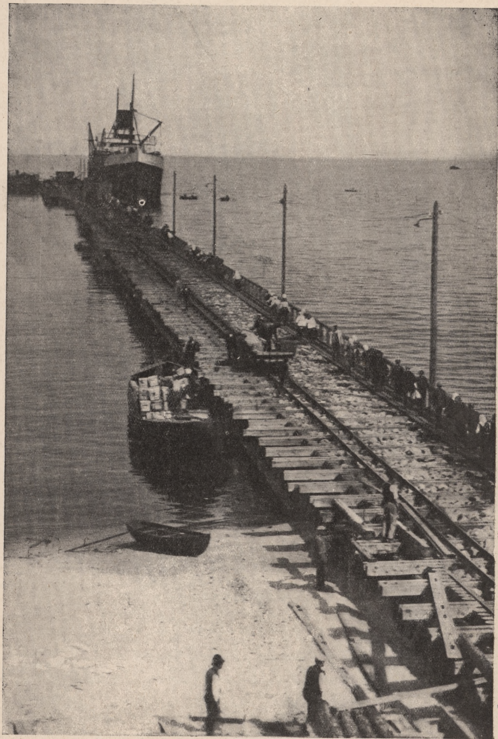
Budowa portu w Gdyni
