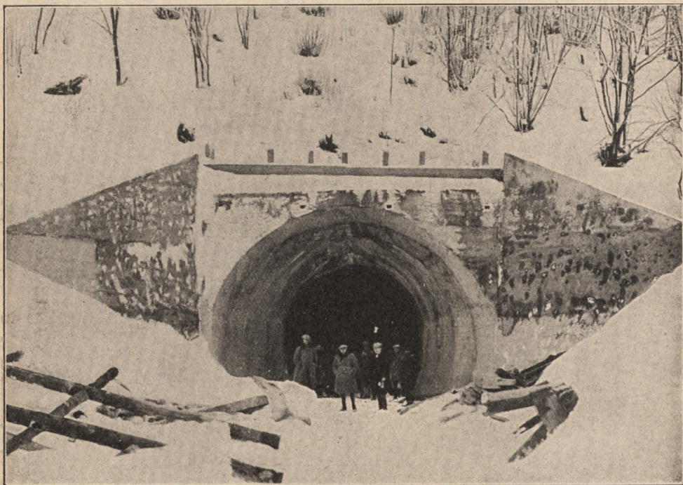
Wejście do tunelu, doprowadzającego wodę do turbin w elektrowni w Myszówkach
