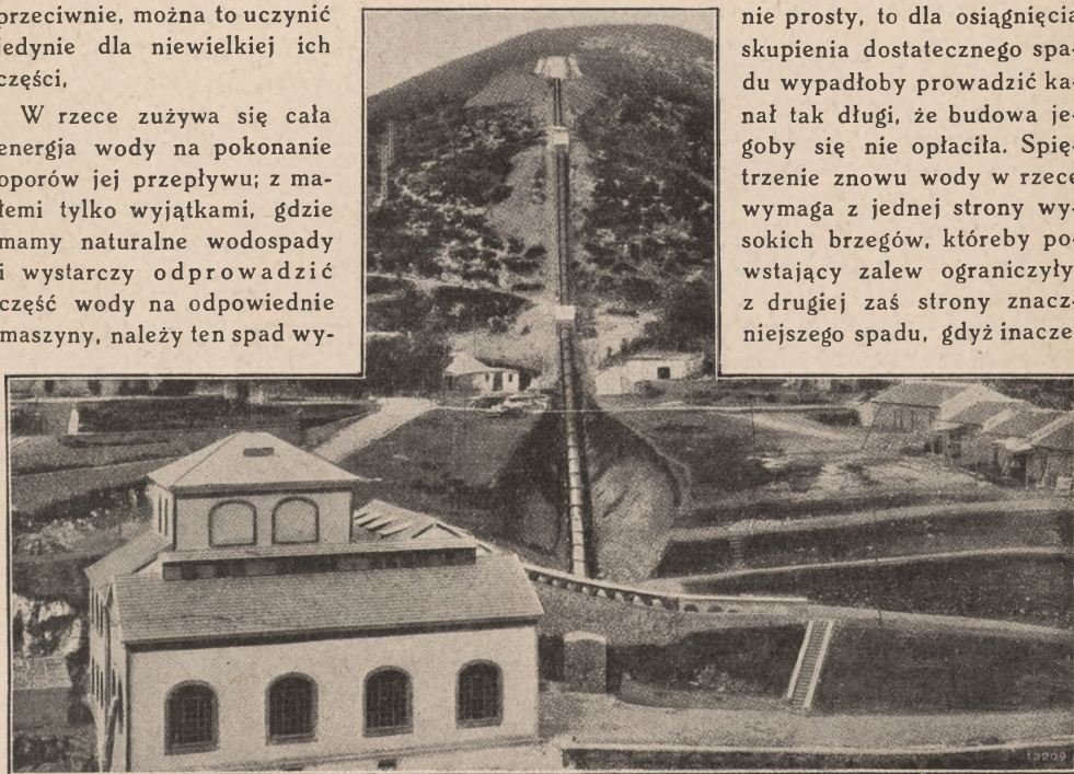
Przewód rurowy, doprowadzający wodę do elektrowni Buitreras w Hiszpanji.
