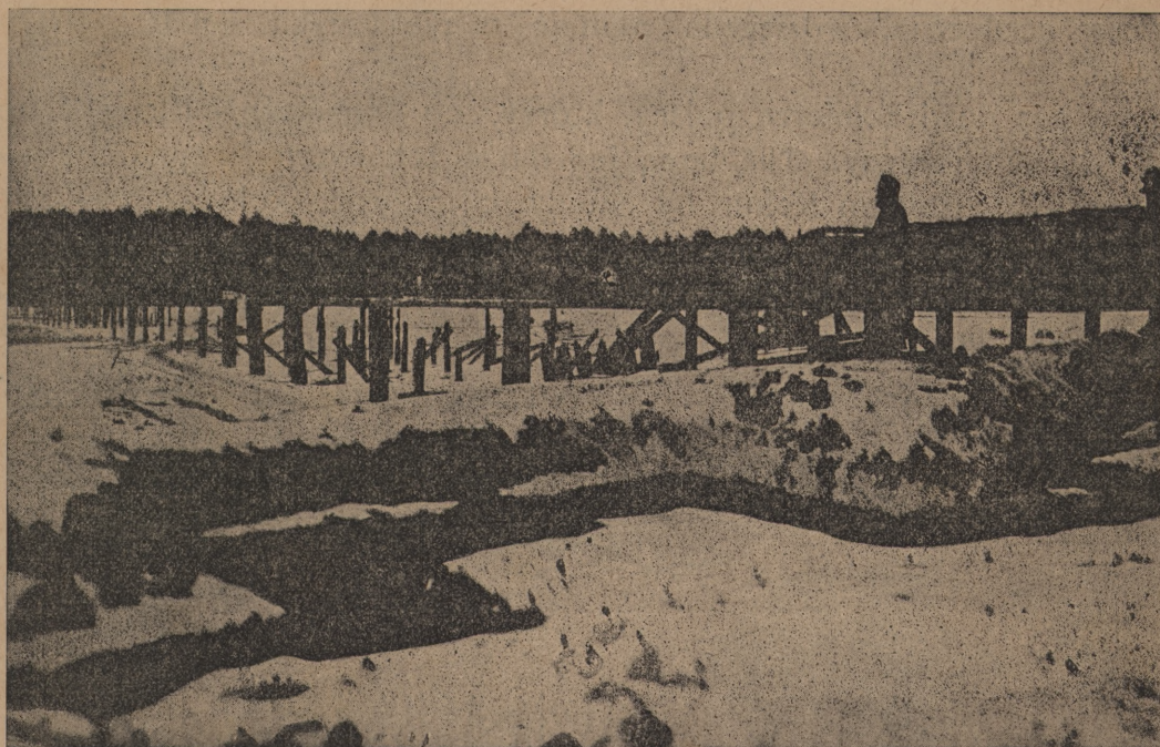
SPALONY MOST NA BEREZYNIE POD LESZCZYNĄ.
