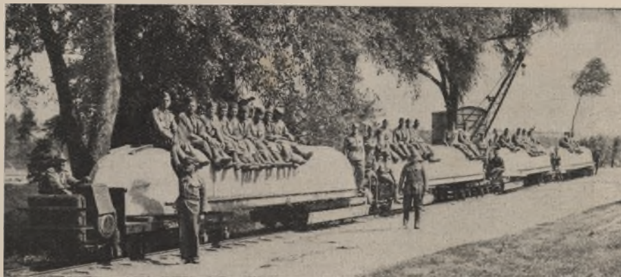
Transport pontonów kolejką polową.
