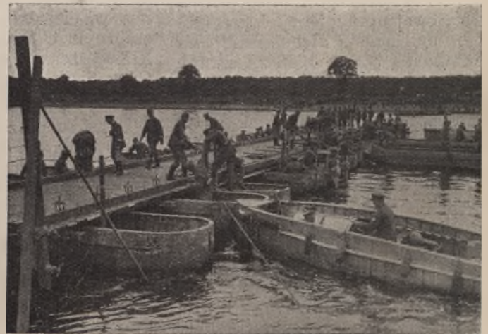
Budowa mostu pontonowego
