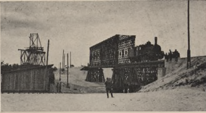
Próba obciążenia mostu, wybudowanego przez 2 baon most. kolej, w czasie 14-dniowej koncentracji
