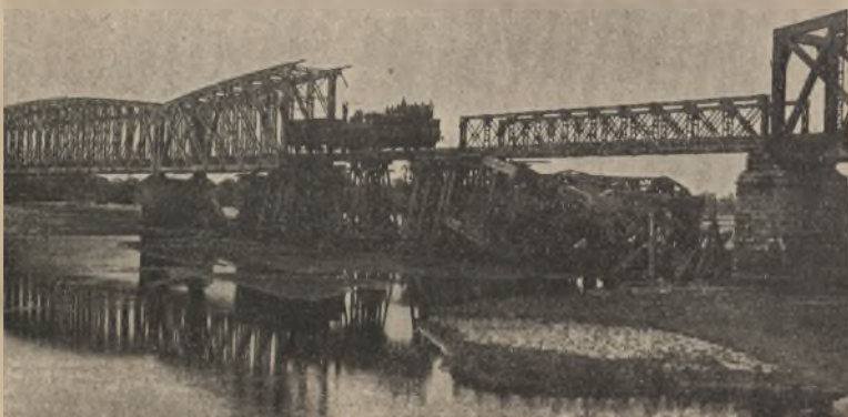
Most na Słuczy, odbudowany prowizorycznie przez dyrekcję Radomską
