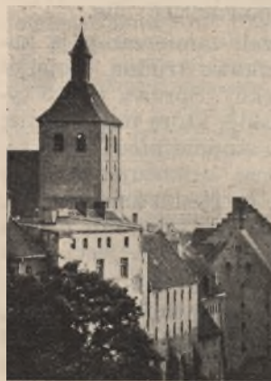
Gotycka fara św. Mikołaja, zbudowana około 1300 roku. Wnętrze kościoła przeważnie barokowe
