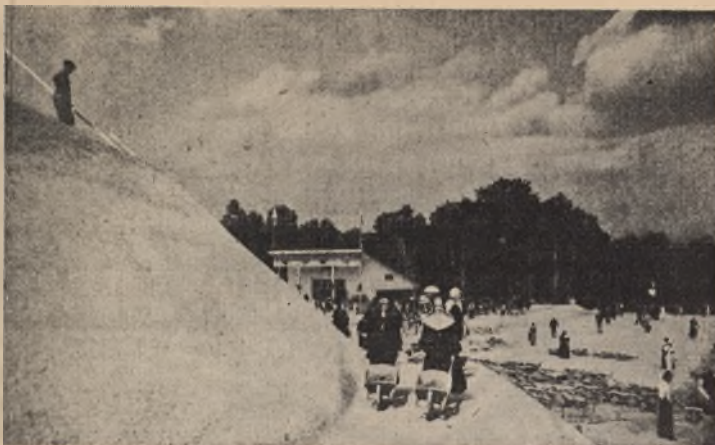
Fragment budowy kopca
