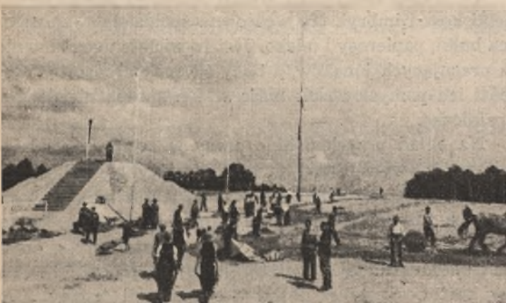
Robocza brygada przy pracy
