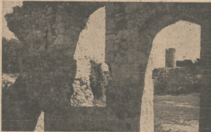
Ruiny zamku Kazimierza Wielkiego. Wieża strażnicza na sąsiednim wzgórzu. Niegdyś zamek otoczony był murem ze strzelnicami i ozdobiony attyką.
