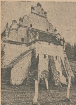
Jeden ze starych śpichlerzów, budowanych z kamienia wapiennego, a częściowo z cegły. Zwracają uwagę pięknie dekorowane szczyty.
