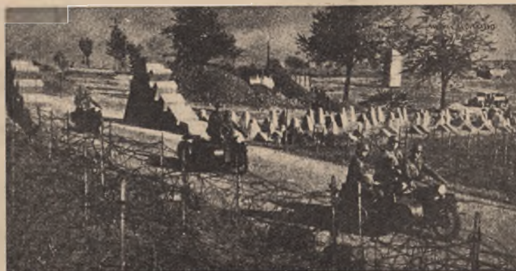
Przeszkody przeciwczołgowe w terenie i na drodze. W tyle widać schron bojowy.
