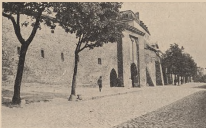
Stare mury obronne Torunia
