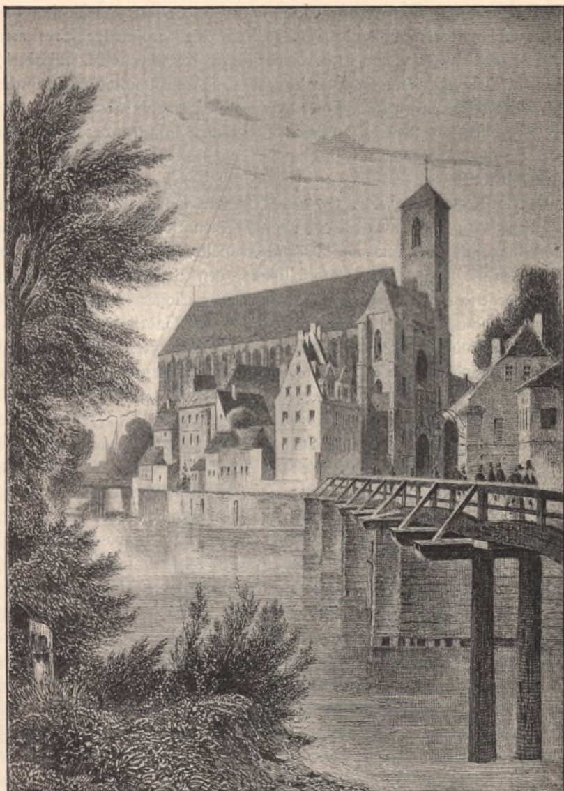
Die alte Sandkirche von der Südseite.
