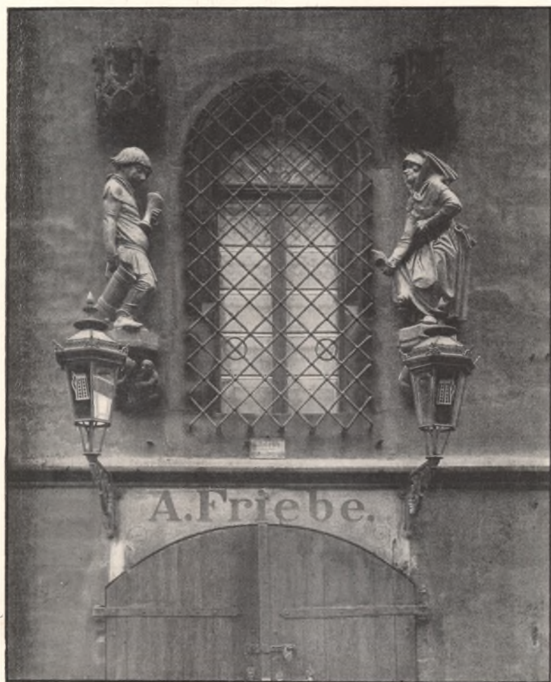
Eingang zum Schweidnitzer Keller. (Vor der letzten Renovierung.)
