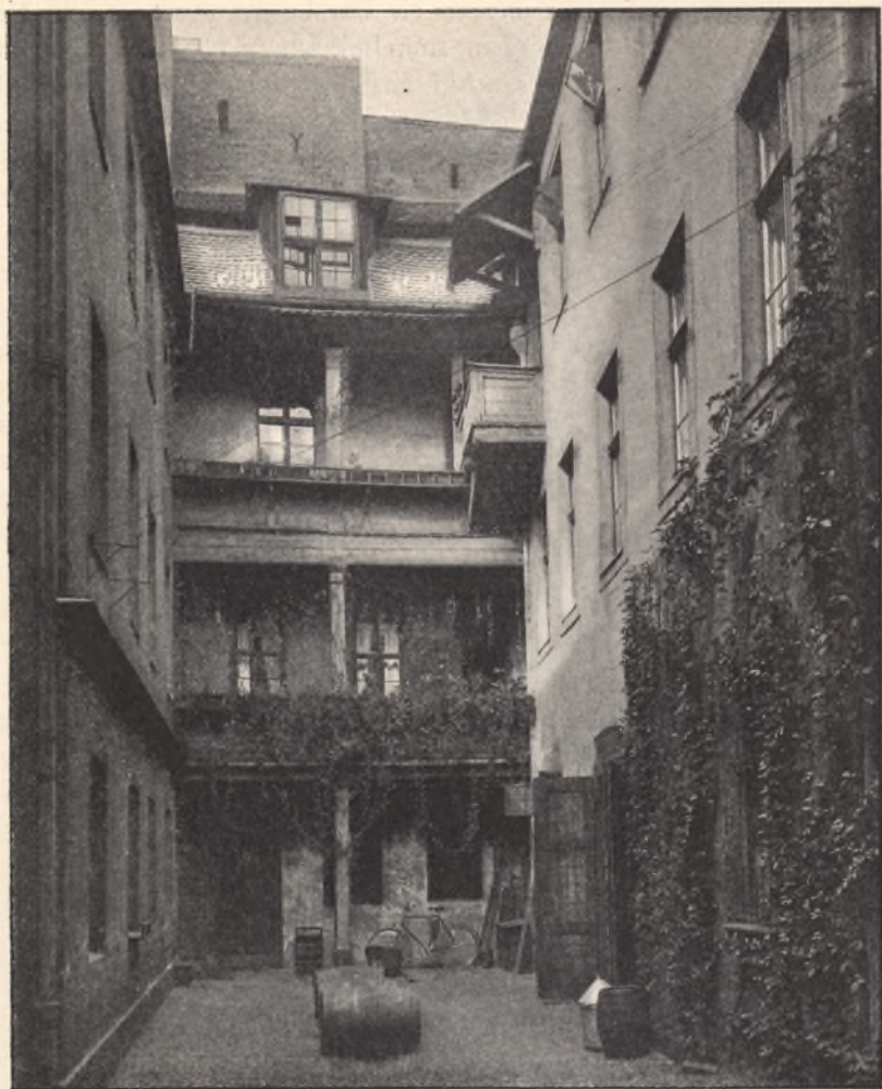
Hof des Hauses Schuhbrücke 50.
