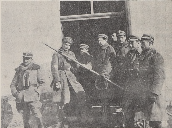
NA PUNKCIE OBSERW. W BETONIARNI
