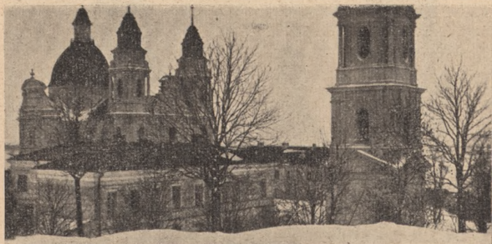
Totalansicht der Kathedrale.
