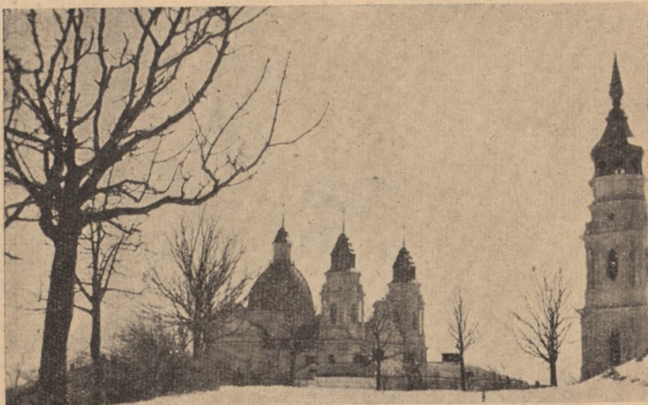
Totalansicht der Kathedrale.
