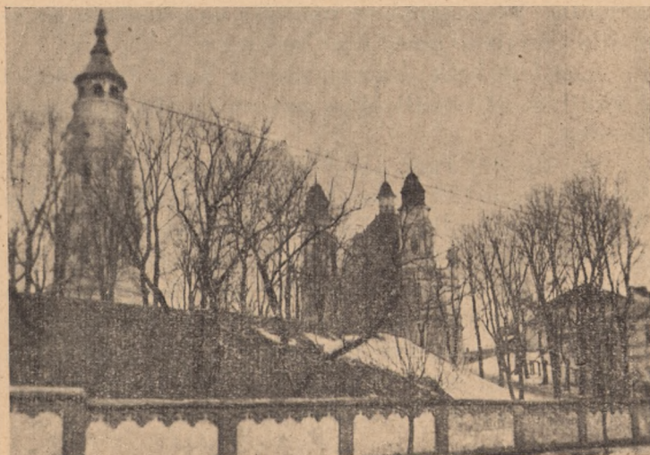
Totalansicht der Kathedrale.
