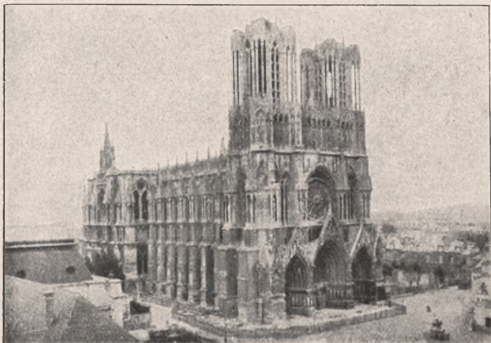
Katedra w Reims po pożarze. Przeciwstawienie wskazuje, że i po pożarze dachu całe rusztowanie architektoniczne jest zachowane i że katedra nie jest w żadnym razie „kupą gruzów“
