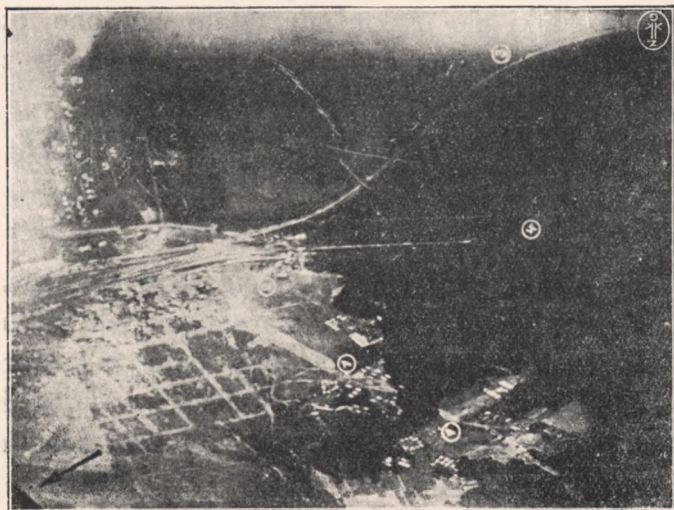
Rys. 26. Zdjęcie dworca i bocznicy, będącej w budowie.
