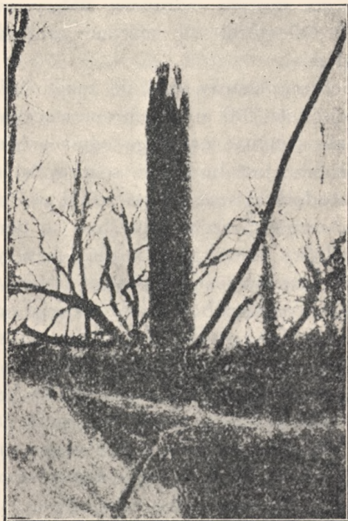
Rys. 25. Sztuczny pień drzewa, w którym jest ukryty obserwator.
