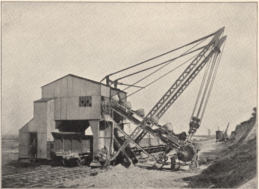
Abb. 3. Hochbagger der Lübecker Maschinenbauanstalt A.-G. für 200 cbm Stundenleistung.
