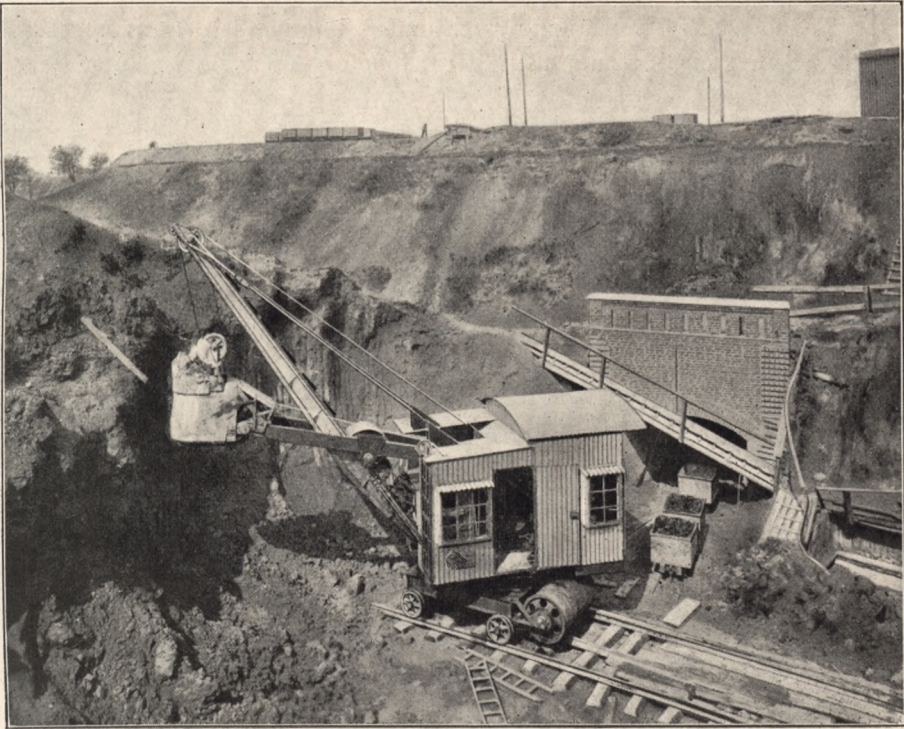
Abb. 12. Drehscheibenlöffelbagger mit elektrischem Antrieb, Bauart Menck & Hambrock. Heinitzgrube.
