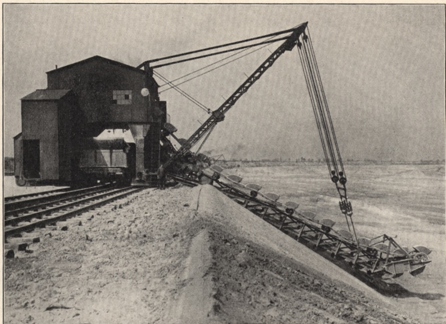
Abb. 7. Tiefbagger der Lübecker Maschinenbauanstalt für 200 cbm Stundenleistung. Fiskalische Sandgewinnung bei Preschlebie.
