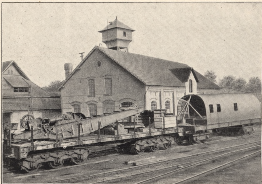
Abb. 13. Eisenbahnlöffelbagger von Menck & Hambrock, fertig zum Eisenbahntransport.
