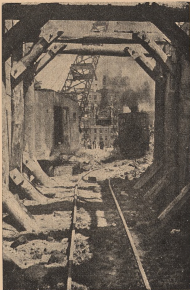
Sztolnia transportowa w tunelu
