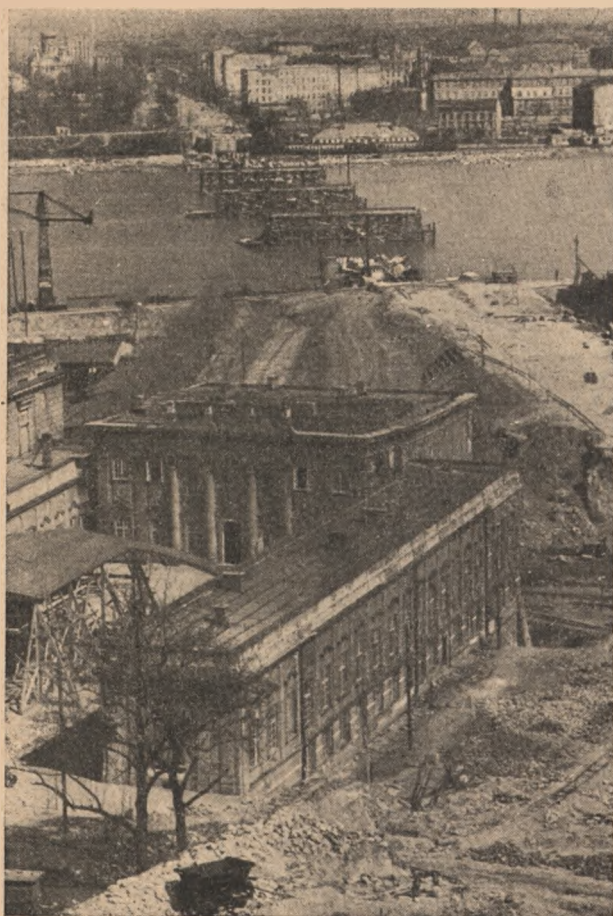
Widok ogólny na teren budowy
