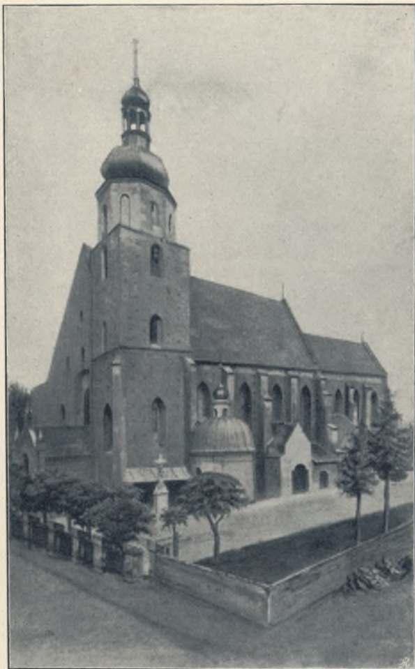
Die Pfarrkirche in Sohrau O/S.
