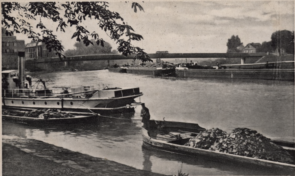
Appeln, Partie an der Oder mit Fährhundertbrücke.
