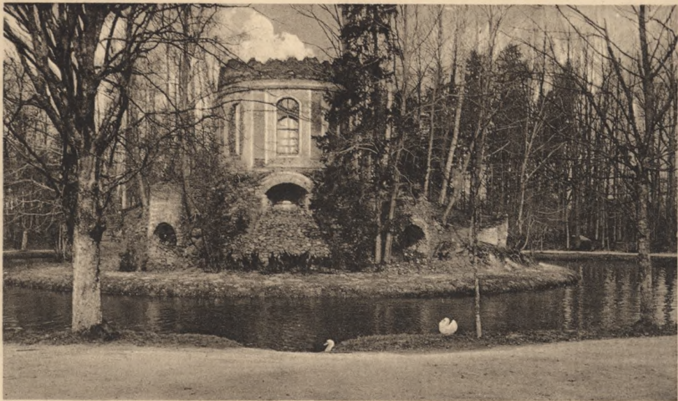
Bad Karlsruhe, Schl., Ruine
