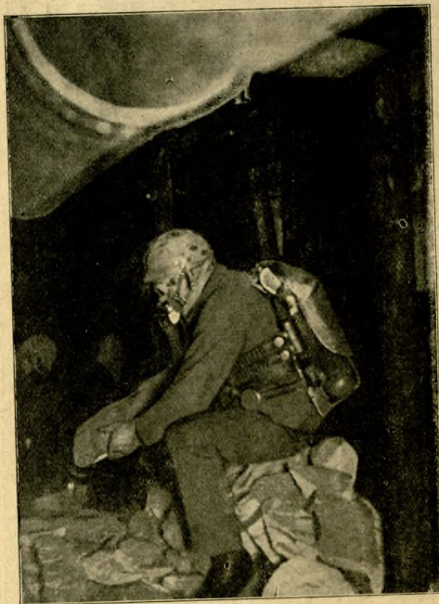
Odkopywanie drogi zasypanej z powodu wybuchu gazów.
