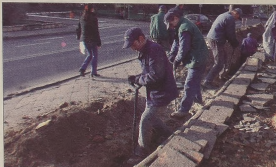
Prace przy układaniu kabla wysokiego napięcia. Na zdjęciu Arkadiusz Falgan, Zygmunt Konon i Zbigniew Grenda z firmy Berus z Opola.
