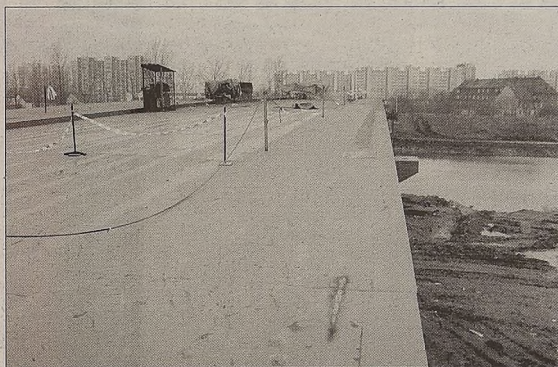
Za pół roku tędy przejadą pierwsze pojazdy, przejadą ludzie.
