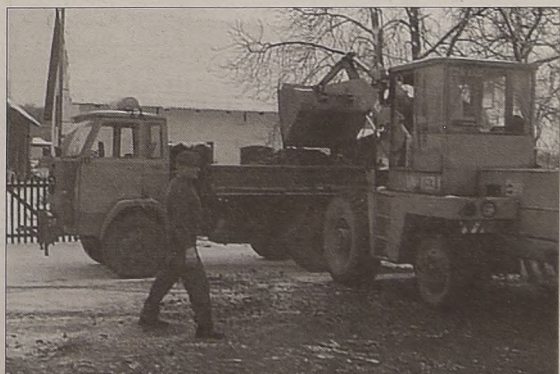
W Paczkowie zmagazynowano kilkadziesiąt ton tłuczni. Kierowca wywrotki Jan Suslik wozi go na drogę do Lesnioków.
