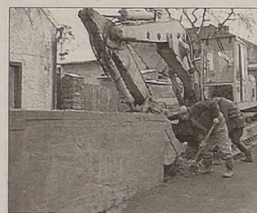
Pracownicy firmy BORBUD z Raciborza budują kanalizację sanitarną na półkilometrowym odcinku ulicy Raciborskiej.
