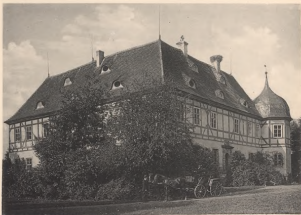
1. SCHÖNBERG OL. BÜRGERHÄUSER AM MARKTPLATZE 2. ROSENTHAL IN DER GRAFSCHAFT GLATZ BAUERNHAUS 3. KROPPEN IN DER OBERLAUSITZ HERRENHAUS . . . . .
