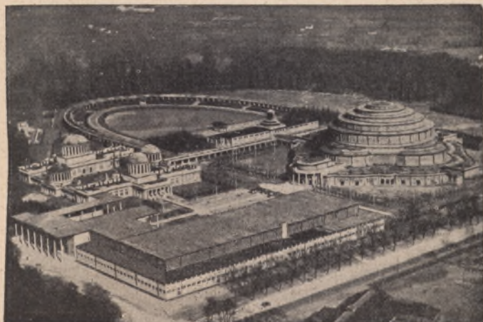
Abb. 57. Ausstellungsgelände zu Breslau mit Jahrhunderthall, Ausstellungsbau und Messehof. Phot. Arcatograph. Institut Breslau. Mit Genehmigung des Verlages C. A. Seemann, Leipzig.
