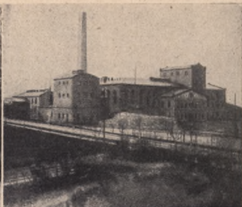
Abb. 55. Eine schlesische Rübenzuckerfabrik von heute.
