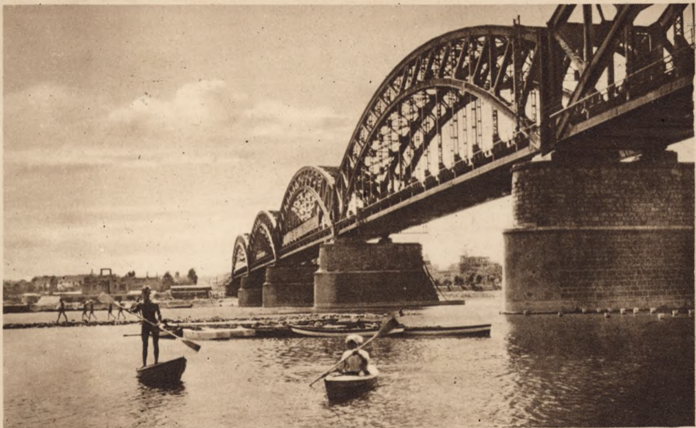
WARSZAWA. Nowy most kolejowy.
