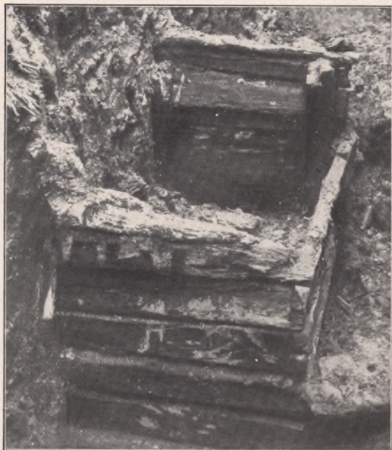
2 Hausede an der Ostwand der Baugrube.
