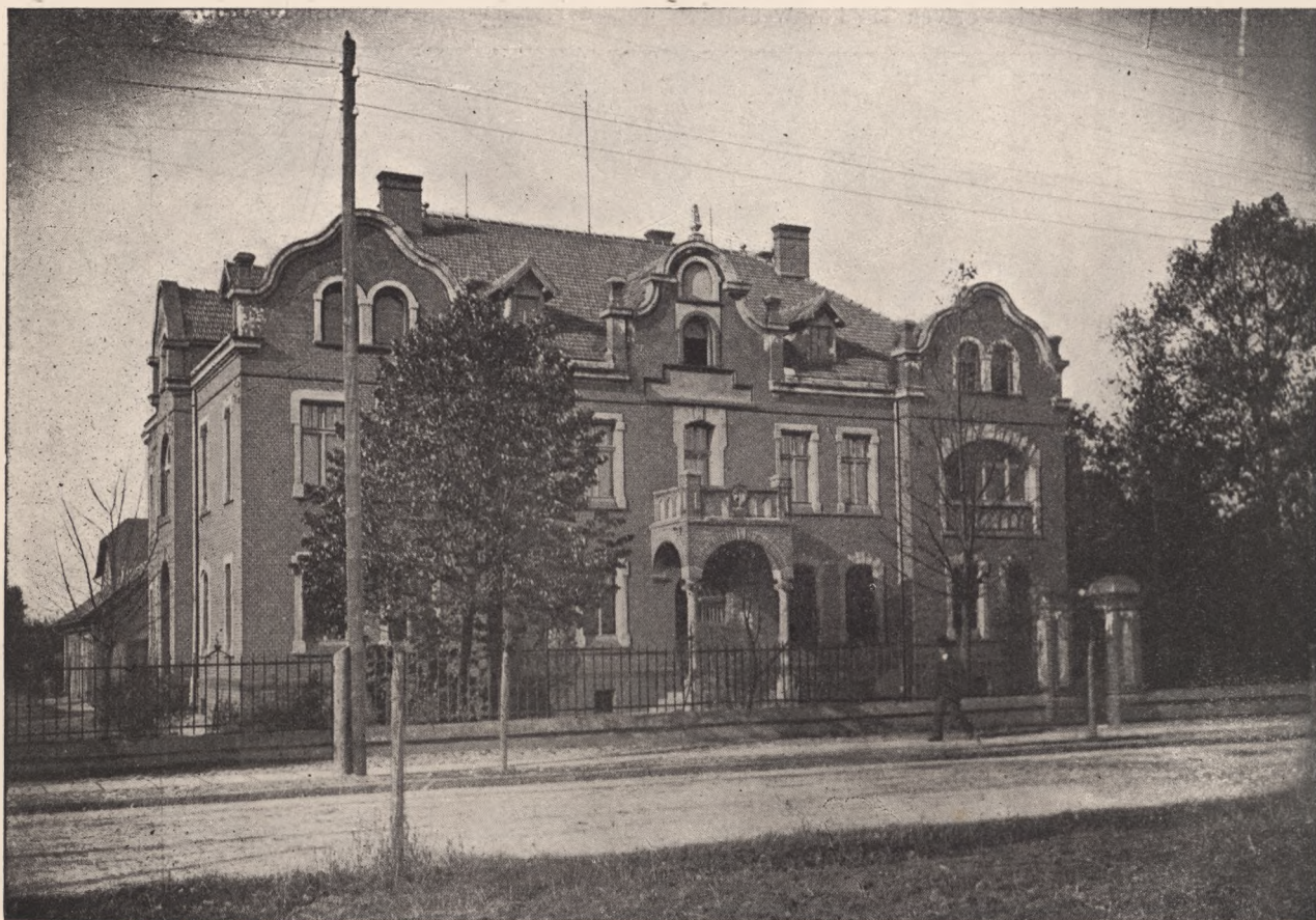
Gmach Urzędu skarb. i Kasy skarbowej w Lublińcu.
