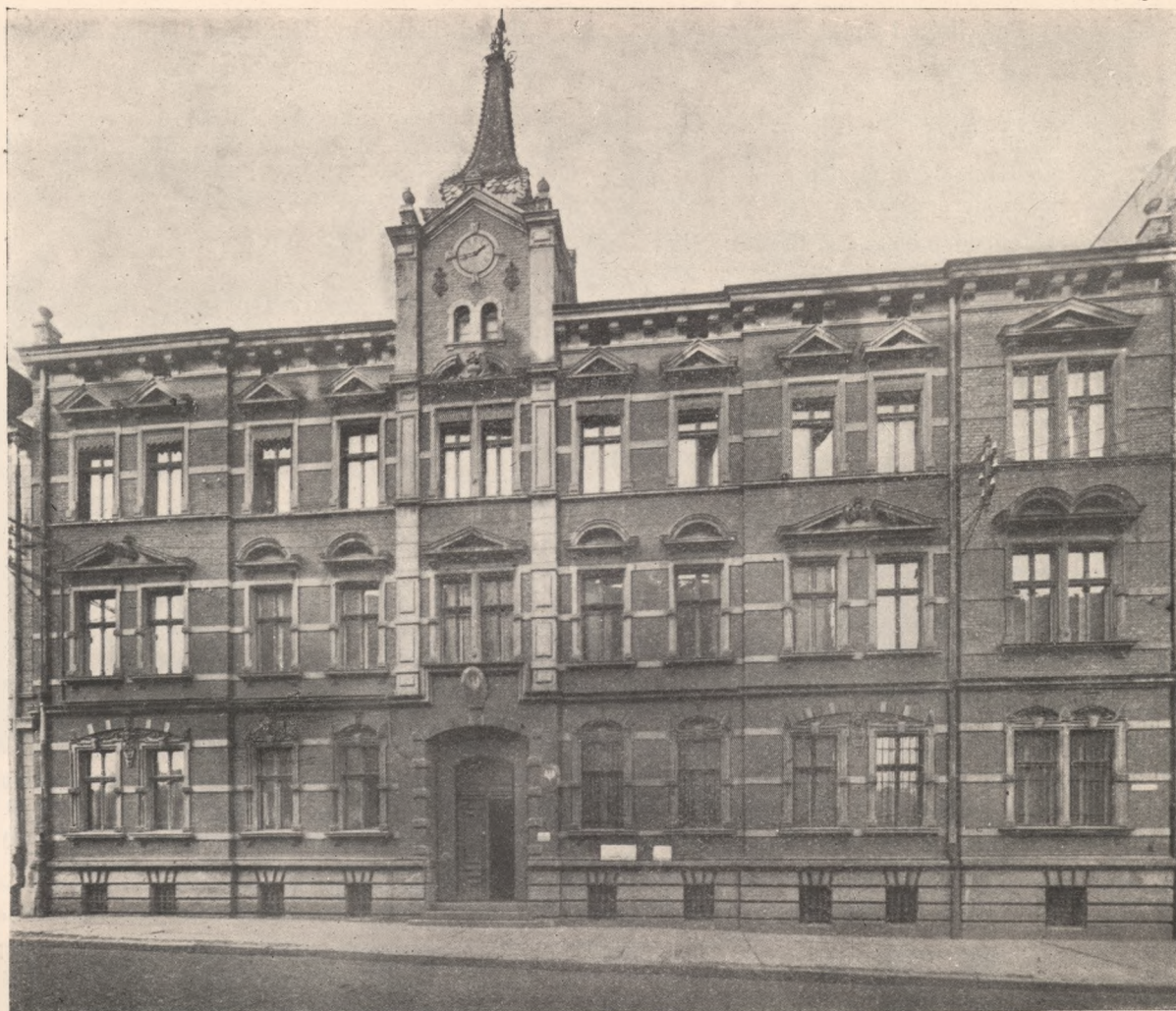
Gmach Urzędu skarbowego w Siemianowicach śl.
