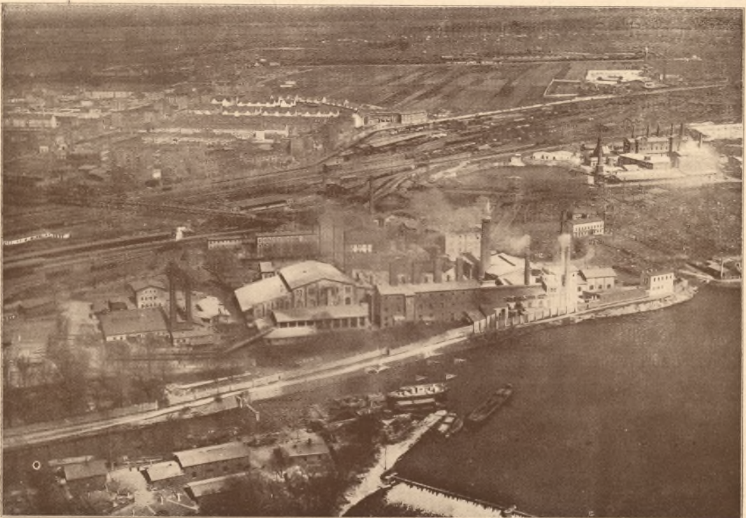
Luftbild Zementfabrik Werk Grundmann
