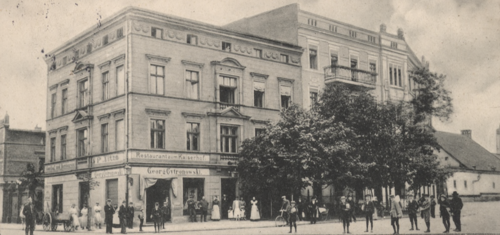
Gruss aus Oppeln. Karlsplatz.
