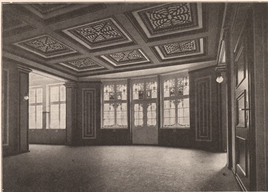
Treppenvorraum im 1. Obergeschoß
