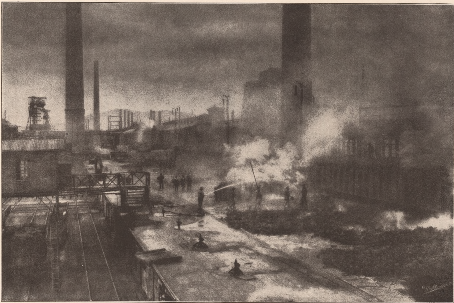
Löschrampe einer Koferei
