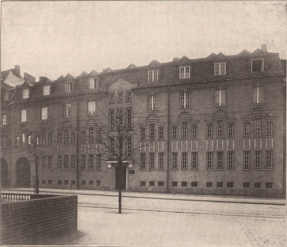
Verwaltungs- und Betriebsgebäude
