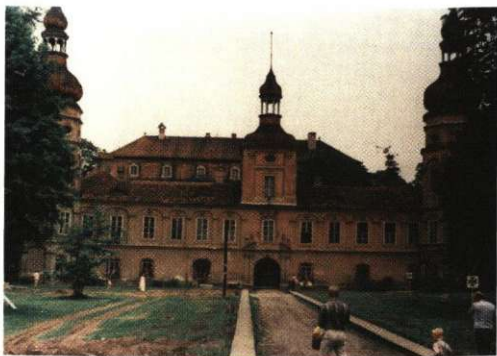
20. Pałac w Żywowej w roku 1986 przed renowacją
