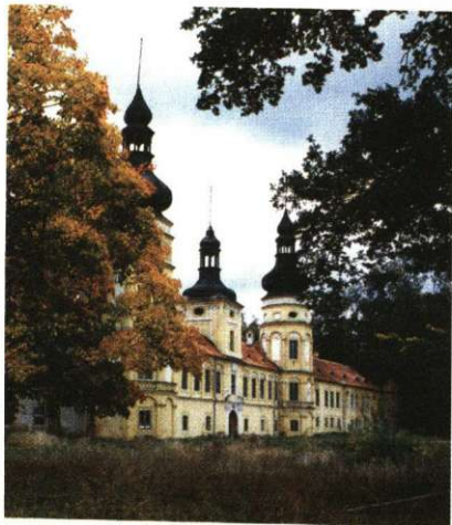
21. Widok pałacu w Żywowej po renowacji przeprowadzonej przez ZRiMUE Remak w Opolu
