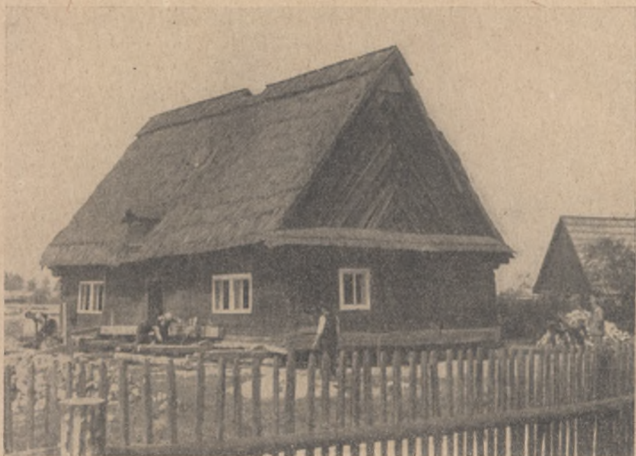
Das Haus ist hochgehoben
