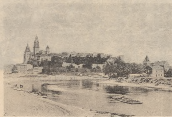
707 Kraków. Ogólny widok Wawelu z Wisłą
